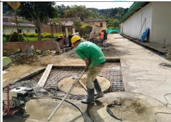
Refuerzo de losas con geotextil irregular intersecciones 13-10-2020
