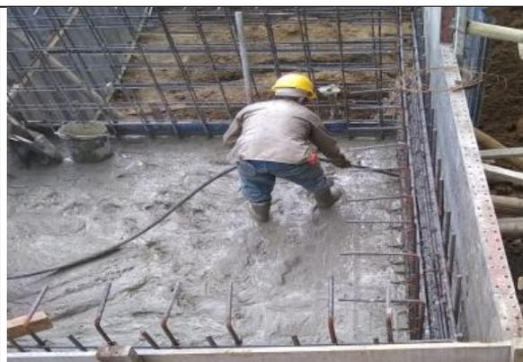
Instalacion Del Concreto Losa De Fondo Planta De Tratamiento
