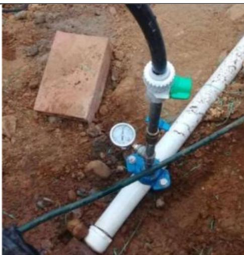
Prueba de presión en la tubería de acueducto
