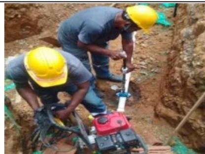
Ejecución de pruebas hidraulicas, limpieza y desinfeccion de tubería
