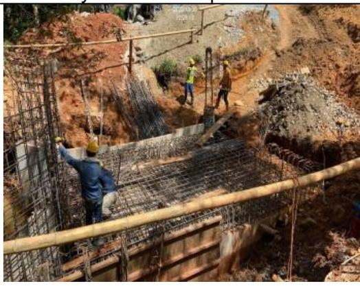
**DESCRIPCION:** Se observa el suministro e instalación del acero de refuerzo bocatoma.
