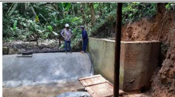
**Avance en Bocatoma principal. Estructura terminada. Pendiente instalación de accesorios y algunas adecuaciones.**
