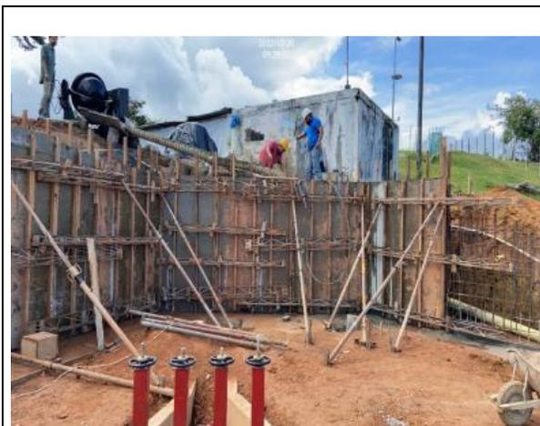
**DESCRIPCION:** Se observan la fundición del muro de contención, contiguo a los floculadores
