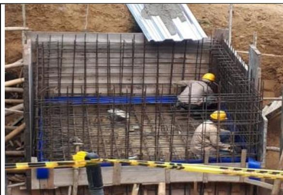
Colocacion De Los Refuerzos De Acero Para La Losa De Fondo Y Muros Planta De Tratamiento.
